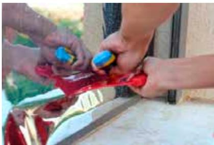
Dann die Folienkanten unter Zuhilfenahme des Lineals und des Cuttermessers zuschneiden: Lineal vertikal stehend parallel zum Rahmen fest auf die Glasoberfläche drücken und Folienkanten mit Cuttermesser in fließender Bewegung von Lineal und Cutter zuschneiden.
