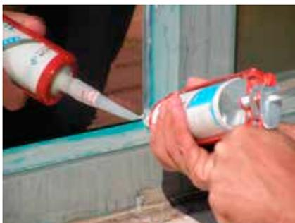
Kantenversiegelung. Sobald die Folienkanten und Fensterrahmen trocken sind, können die Folienränder randversiegelt werden.
