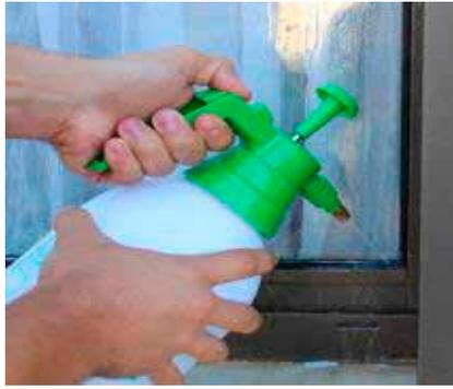
Glasfläche mit Montagelösung einsprühen und mit Glasschaber gründlich abziehen. Fenster und Fensterrahmen dann gründlich mittels Wischer und Montagelösung reinigen - Eck- und Kantenbereiche besonders gründlich - Flüssigkeit abziehen und trockenwischen. Glasfläche wieder einsprühen.
