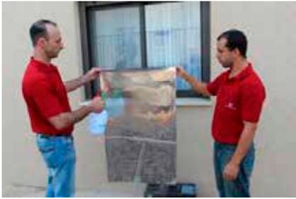
Den Liner abziehen und gleichzeitig die freigelegte Klebefläche mit der Montagelösung gründlich einsprühen. (Am besten von einer zweiten Person helfen lassen). Auch die Fensterfläche nochmals gründlich einsprühen.
