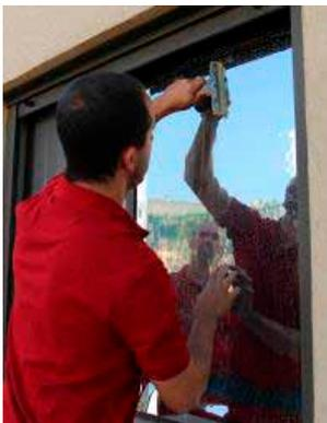
Dann die Folienoberfläche besprühen und die Folie mit dem Squeegee von der Mitte aus beginnend mit Seit- und Abwärtsbewegungen anrakeln. Sicherstellen, dass alle Luft- und Wasserblasen ausgerakelt werden.
